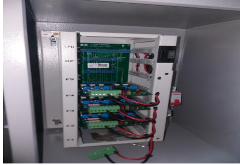
Figura 1: Circuito das fases do semáforo
